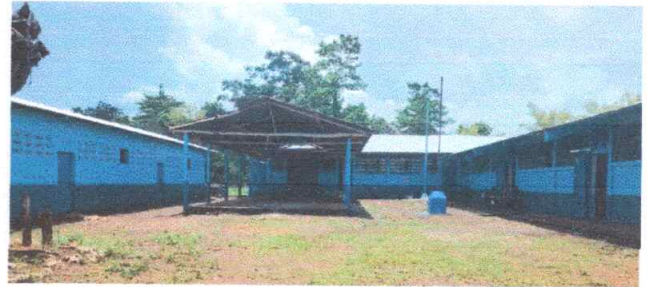
Foto 4: Trabajo finalizado de las tres escuelas.
